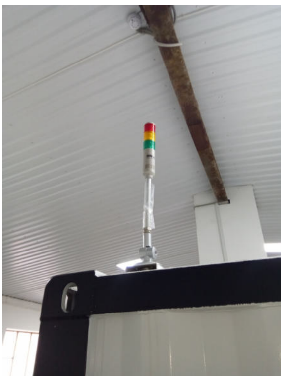
Сигнальная мачта при проведении высоковольтных испытаний
