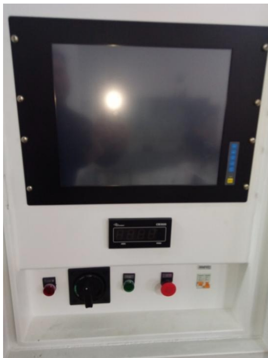
Пульт управления и измерения в низковольтном отсеке (автоматический, на базе промышленного компьютера с сенсорным экраном или вариант с ручным управлением)
