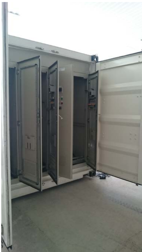
Низковольтный отсек со шкафами питания, управления с контроллером MITSUBISHI
