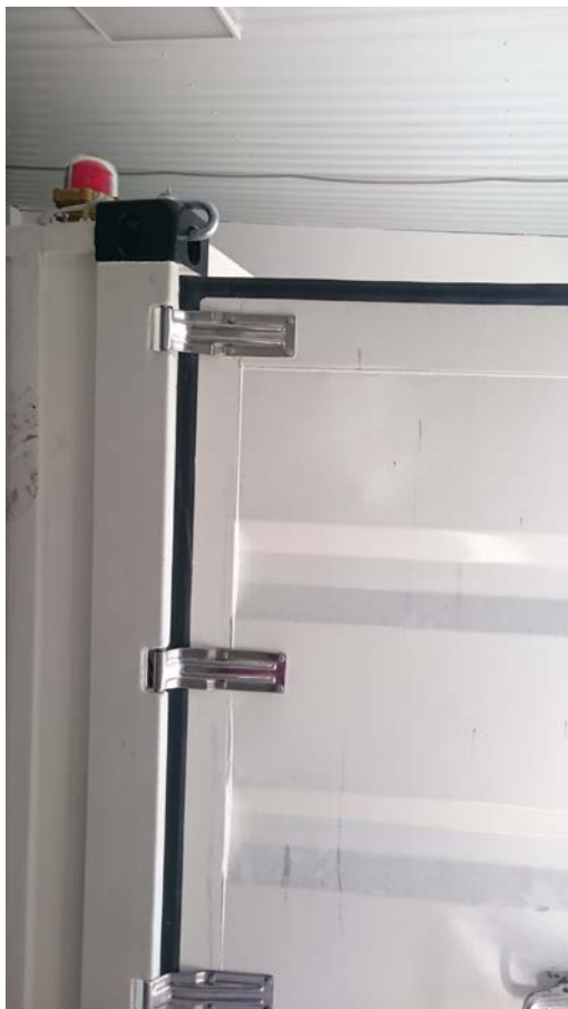
Сигнальная лампа при проведении высоковольтных испытаний
