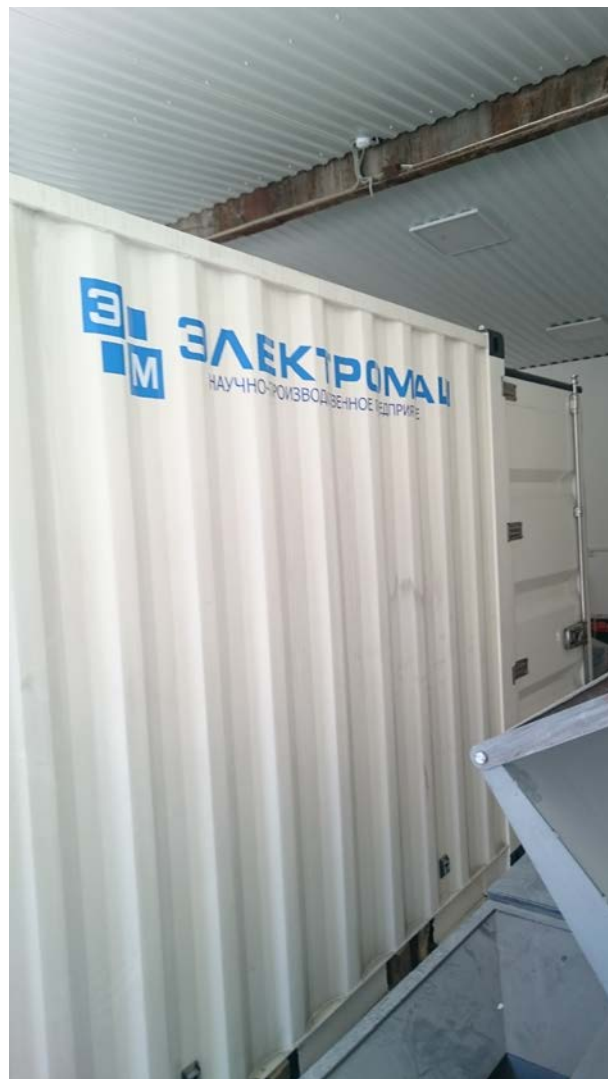
Вид сбоку корпуса- контейнера
