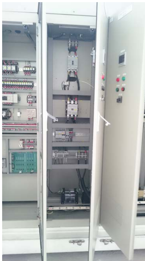
Низковольтный отсек со шкафами питания, управления с контроллером MITSUBISHI
