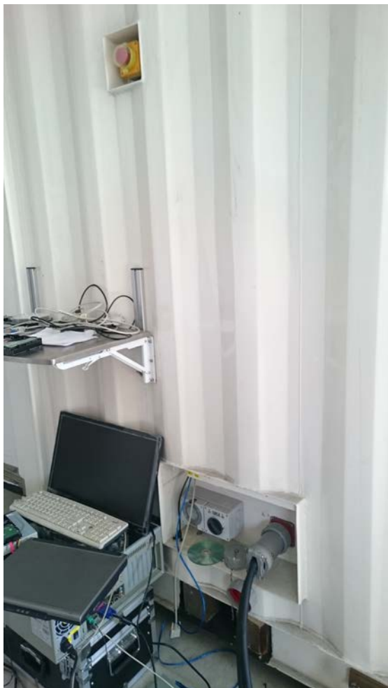
Разъемы для подключения питания, ноутбука для автоматического управления
